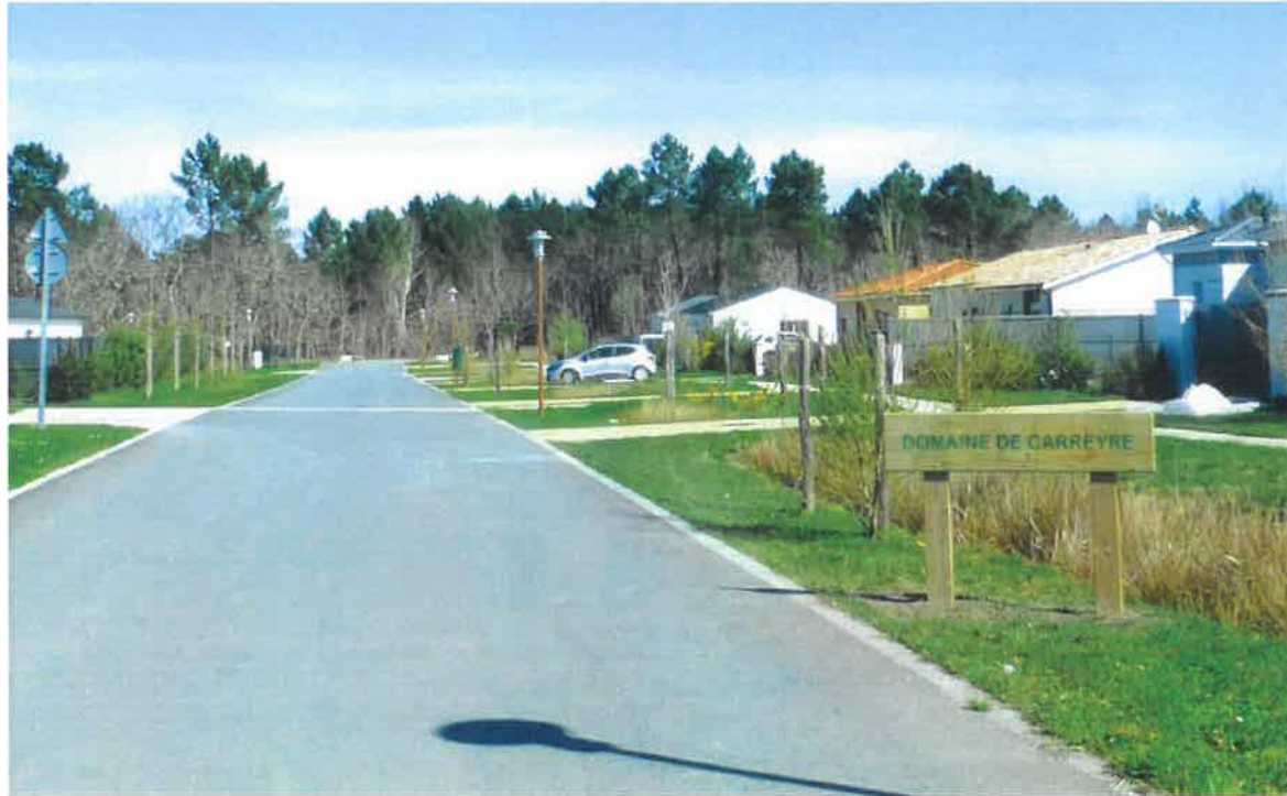
Une chaussée en enrobé avec des bordures basses pour laisser l'eau s'infiltrer dans le sol vers les noues.
