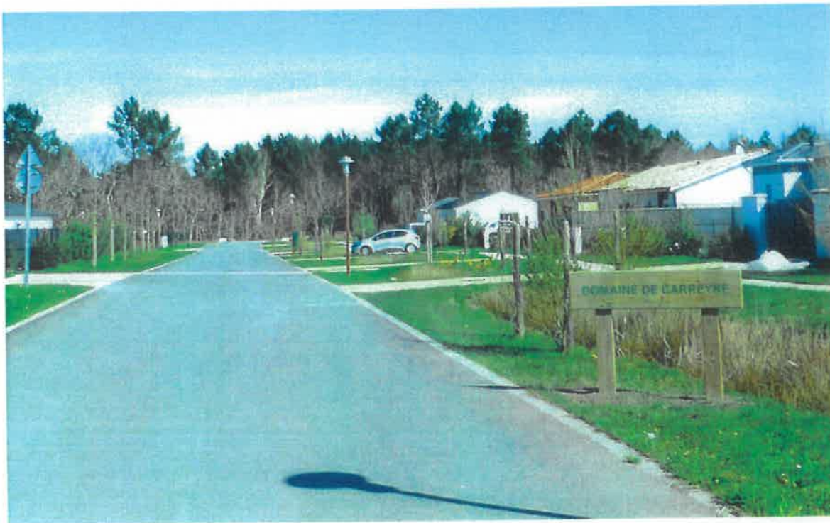
Une chaussée en enrobé avec des bordures basses pour laisser l'eau s'infiltrer dans le sol vers les noues.
