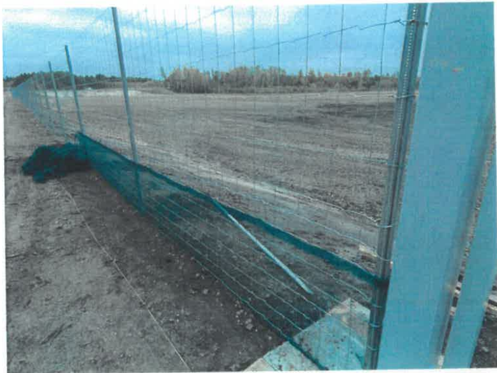
Clôture Type clôture à grillage mouton galvanisée maille 100x150mm sur fer en T, avec en phase chantier ( en fond de lot) la pose d'un filet à maille très fine
